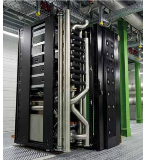
Über 1 MW Kühlleistung für direkte Chipkühlung mit Wasser. QUELLE: Rittal GmbH & Co. KG
